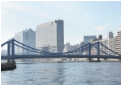
ドイツ・ケルン河に架かる橋をモデルにして造られた「清洲橋」
