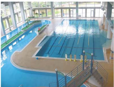
和名ヶ谷スポーツセンター内温水プール
