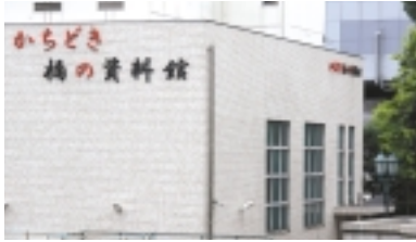
かちどき 橋の資料館外観
