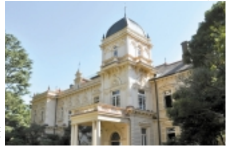
「旧岩崎邸庭園」を代表する、築113年の洋館
