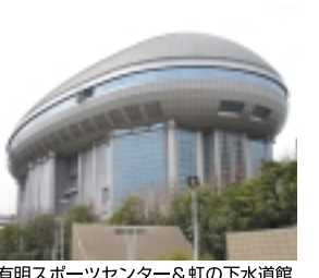
有明スポーツセンター&虹の下水道館
