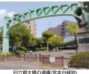
旧六郷大橋の遺構(宮本台緑地)
