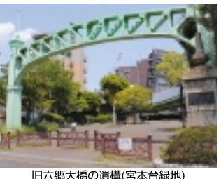
旧六郷大橋の遺構(宮本台緑地)
