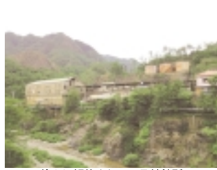
徐々に解体されている精錬所
