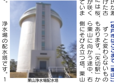
栗山浄水場配水塔
