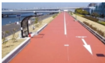
ヒートアイランド現象への対策として、熱交換塗料を処理しているサイクリングロード。アスファルトの場合に比べ、裸足でも歩ける暑さ
