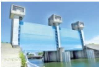
松戸水門。江戸川の水位が上がった時に坂川への逆流を防ぐ等、水量を調整する役割をする
