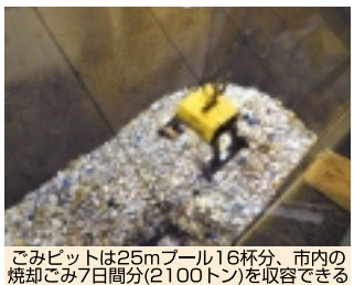
ごみピットは25mプール16杯分、市内の焼却ごみ7日間分(2100トン)を収容できる
