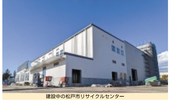
建設中の松戸市リサイクルセンター
